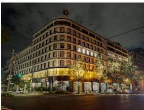
大阪ガスビルディング
